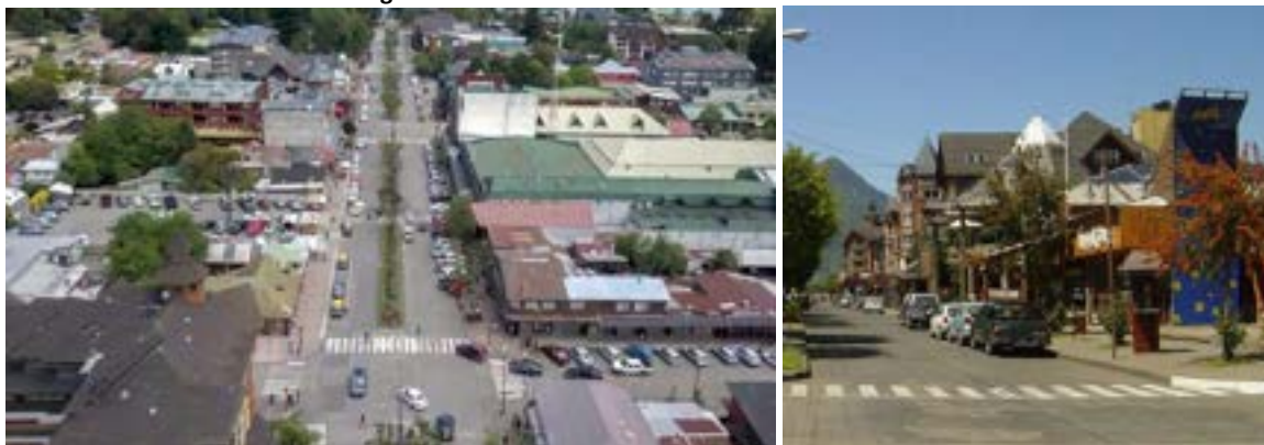
Figura Nº 2-23 Estacionamientos en calzada en Pucón
